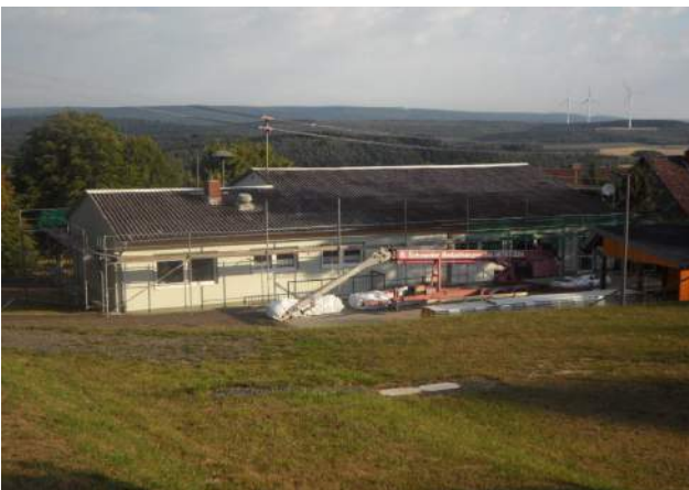
Abbildung 10: Dorfgemeinschaftshaus mitten in der Dachneueindeckung und Errichtung der Photovoltaikanlage
